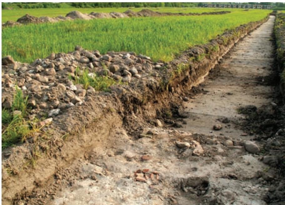
I sommer ramte museets gravko den gamle Korporalskro ved stranden. De store sten stammer fra kroens stenlægning. Lidt teglrester ses i forgrunden. I baggrunden anes husene fra Trylleskovparken. Foto: K. Ejdorf 2007
